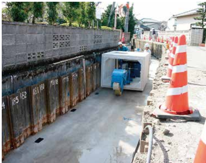
熊本市役所中島町第1号線道路改良工事
