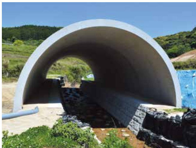
佐賀県伊万里土木事務所 国道204号(伊万里市波多津町木場地区) B10000×H7800
