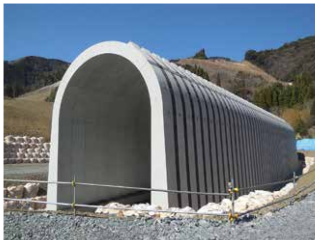
国土交通省延岡河川国道事務所 九州中央道(深角東地区) B6800×H8600
