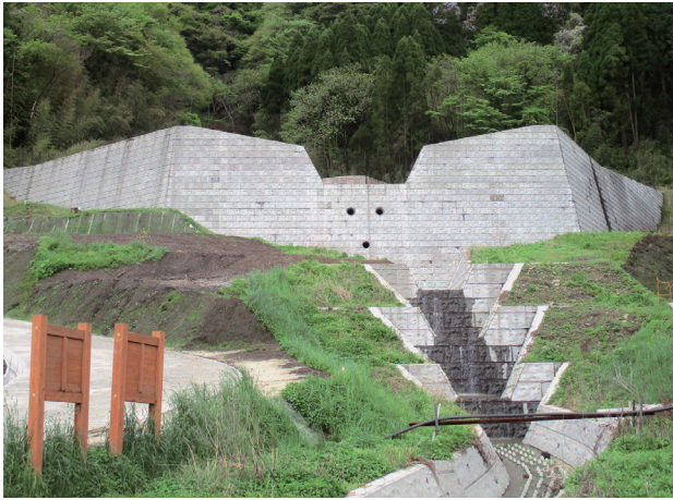
熊本県土木部 災害関連緊急砂防事業 野中川3砂防堰堤
