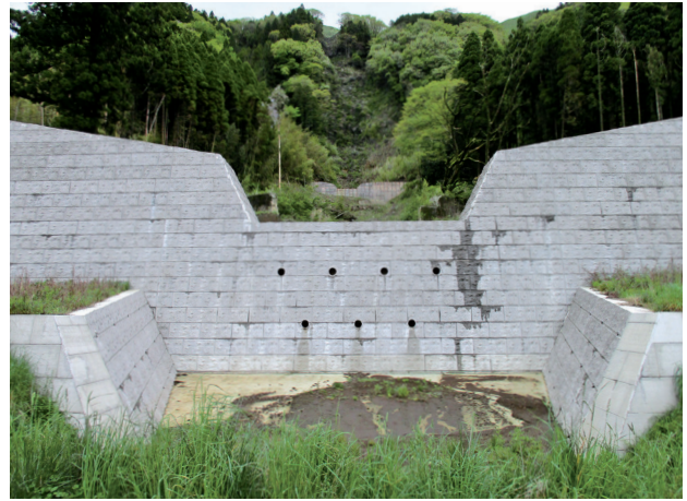
熊本県土木部 災害関連緊急砂防事業 阿蘇品川砂防堰堤
