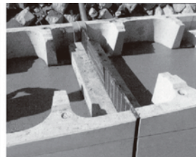
目地材・中込打設
