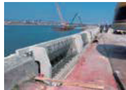
8. 波返し本体ブロック及び鉄筋設置
