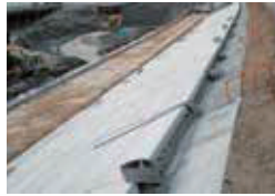
7. コンクリート打設(1段毎)
