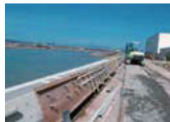
9. 型組・コンクリート打設・完成
