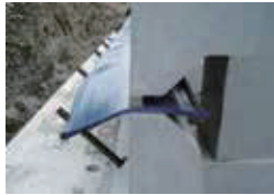
2. 止水板・タイバー設置
