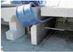
6. 目地材・スリップバー設置
