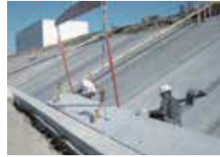
4. コンクリート被覆ブロック設置
