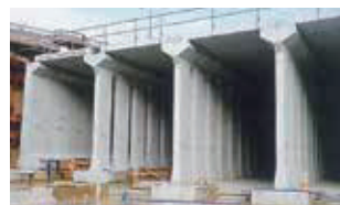
底版コンクリート打設
