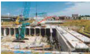
施工状況(全景)
