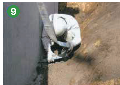
グラウト工 (ピット部)
