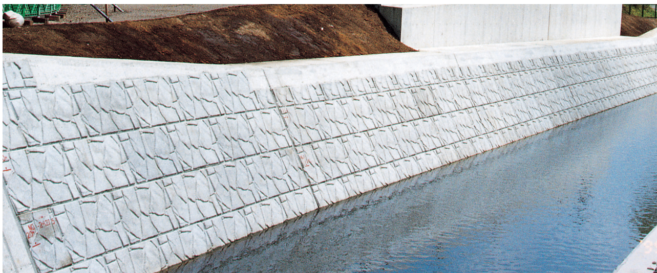
熊本土木事務所発注 山西大津線道路改良
