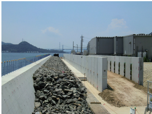
L型擁壁(塩害対策)
