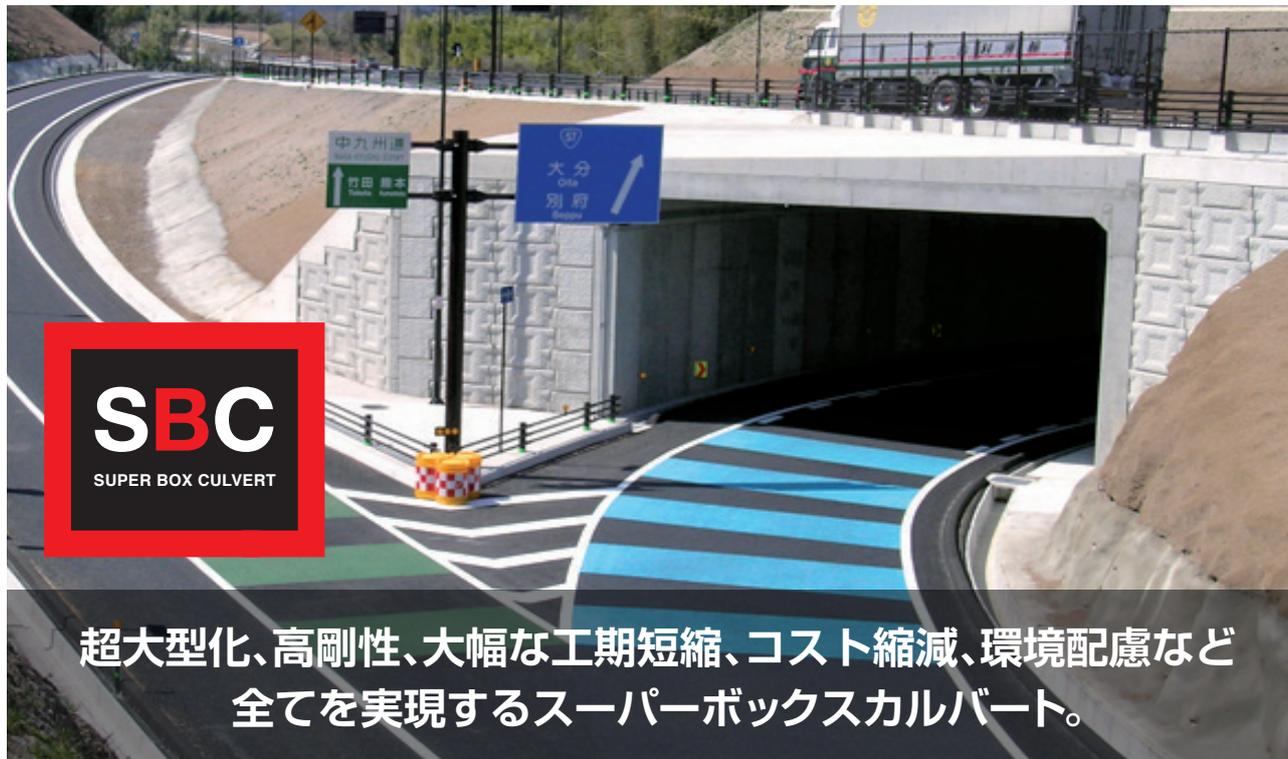
従来現場で打設されていた大型鉄筋コンクリート構造物を、工場で分割製造し現場で組み立てるスーパーボックスカルバート。最大幅13mまでの超大型断面の構築が可能です。頂版(ヘッドスラブ)と側壁(サイドウォール)部材に
